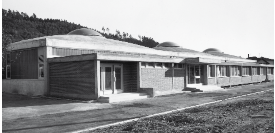
Neubau an der Zeughausstrasse 19 in Wangen (1964). Foto Roth, Herzogenbuchsee
