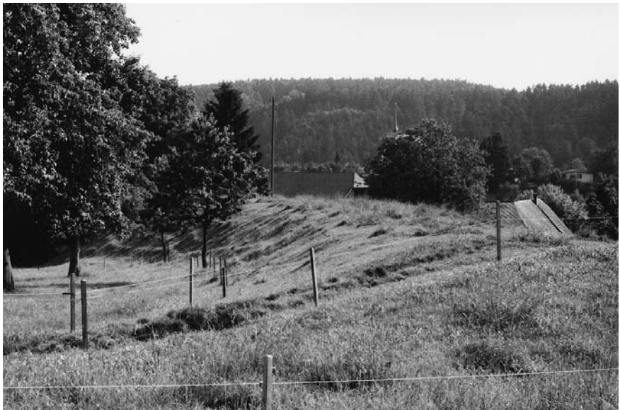
Bahndamm in Altbüren; Blickrichtung ost-west; gegenwärtiger Zustand. Foto Verfasser
