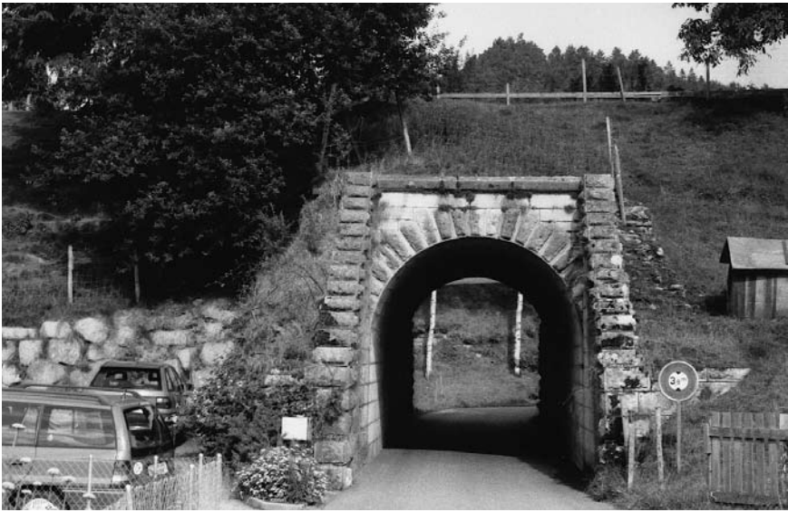
Weg-Unterführung des Bahndammes in Altbüren; gegenwärtiger Zustand. Foto Verfasser
