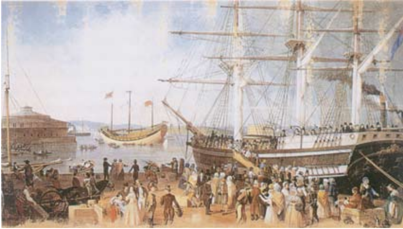
Hafen von New York. Rechts Dreimaster mit irischen Einwanderern. Links das ehemalige Theater Castle Garden, das nun als Aufnahmegebäude für Einwanderer diente. Rundbild von Samuel Waugh, 1855.
